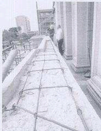
Fotos en la que se prepara el refuerzo de acero apropiado y el recubrimiento Necesario del mismo para evitar filtración de agua y evitar oxidación del Acero y por consiguiente la explosión del concreto
