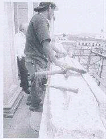
Fotos en la que se prepara el refuerzo de acero apropiado y el recubrimiento Necesario del mismo para evitar filtración de agua y evitar oxidación del Acero y por consiguiente la explosión del concreto
